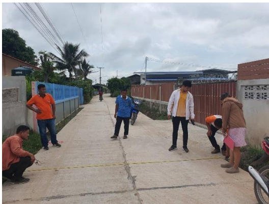
โครงการถนนคสล.สายบ้านโคกวัดหมู่ที่ ๓ หมู่ที่ ๑ หมู่ที่ ๔ (ศูนย์ผลิตอาหาร)
